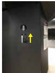
感震装置リセットレバー 解除方法:レバーを上を持ち上げます。
