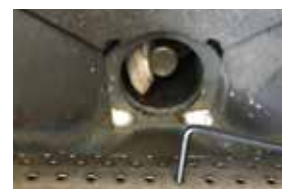
燃焼ポット給気口の清掃
